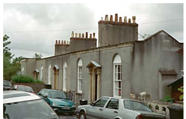
Figure 37: Nos. 1 - 5 (odd) Trelawney Road
