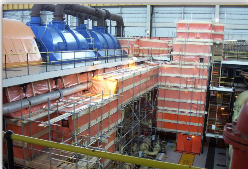
Llun 3 - Tynnu Asbestos o Neuadd y Tyrbin yn Safle A Hinkley Point
