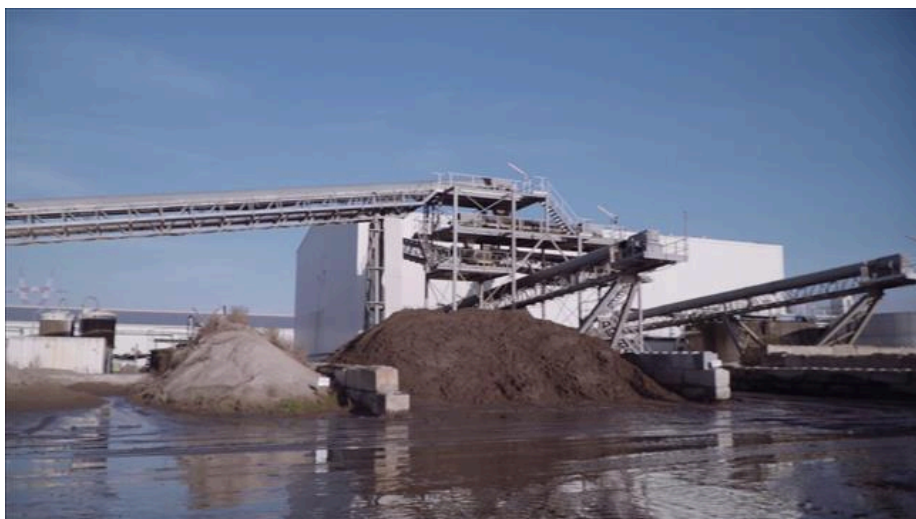
Une plateforme de terres polluées intégrée à Grimbergen, en Belgique
