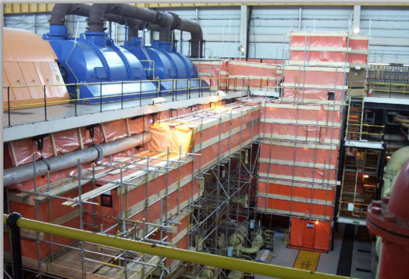
Ffotograff 3 - Tynnu Asbestos o'r Neuadd Dyrbinau yng Ngorsaf Bŵer Hinkley Point A
