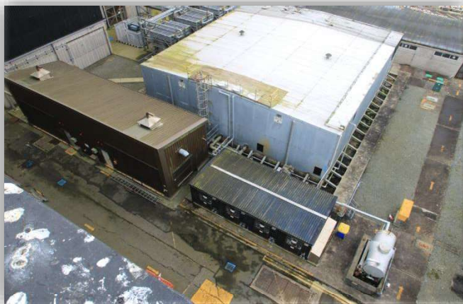
Ffotograffau 10 ac 11 System fwydo wrth gefn, tŷ pwmp bwydo trydyddol/tanc dŵr/tanc tanwydd, rheiddiaduron banc dwbl STT/tanc tanwydd cyn ac ar ôl
