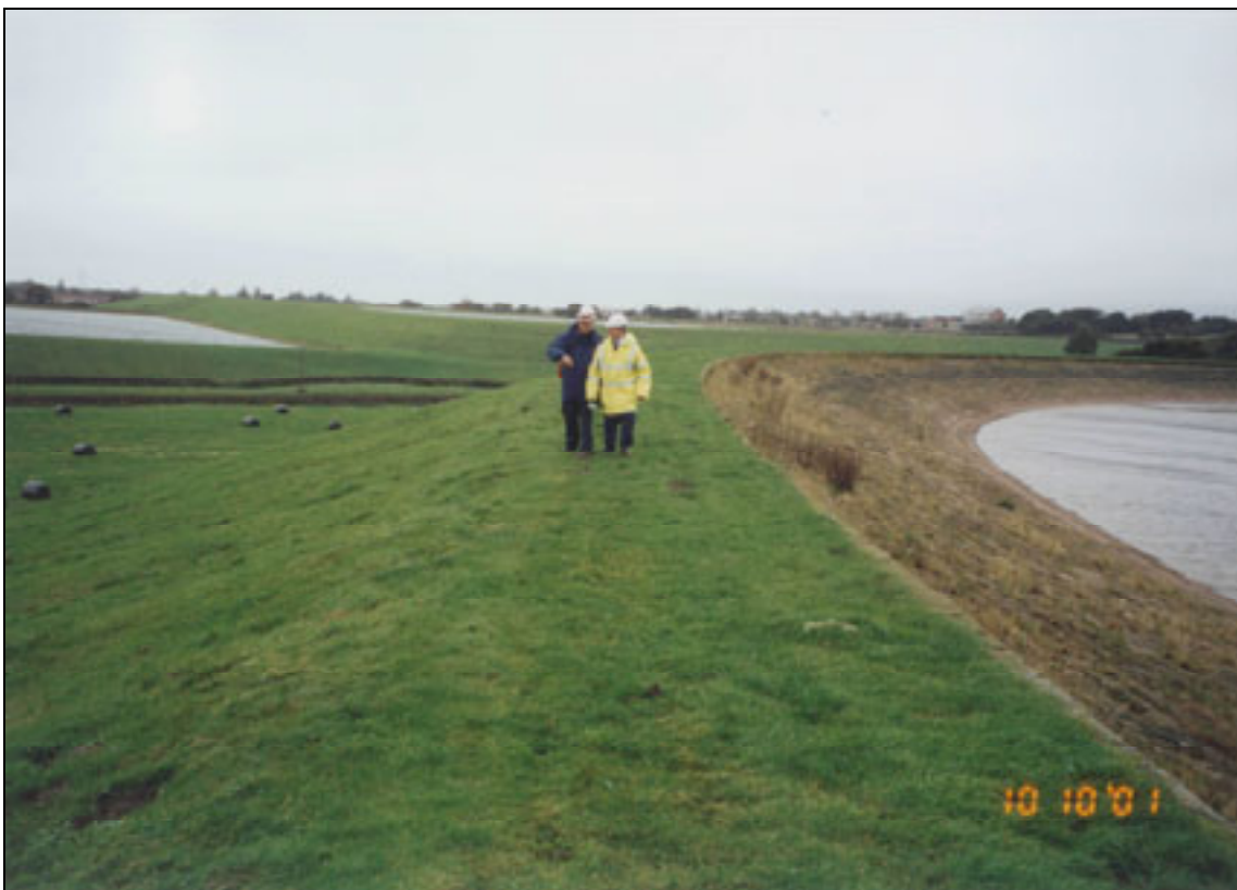
Plate A2.5 Embankment dam (bunded reservoir)
