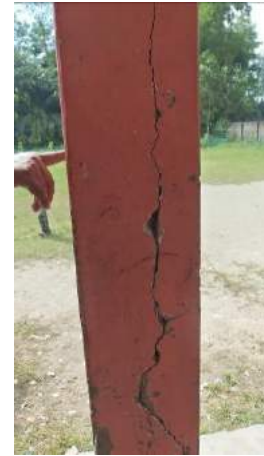
(d) Cracking of concrete in column
