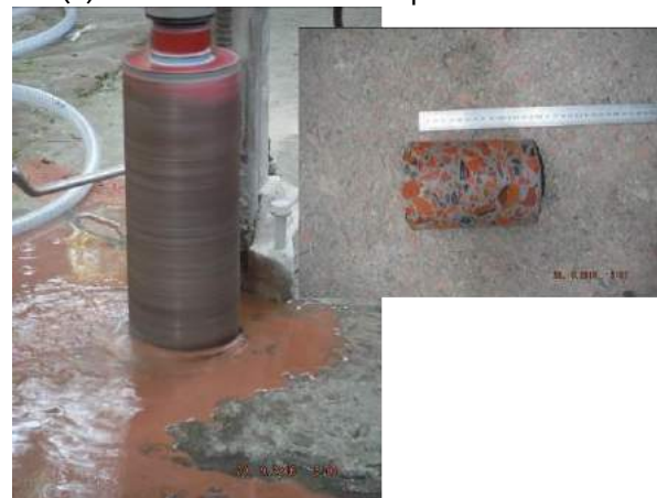
(d) Concrete core collection
