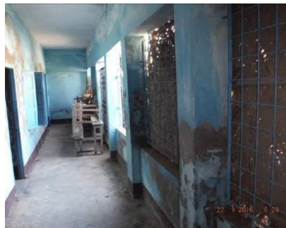
(d) School Corridor - Longitudinal cracks in columns and beams
