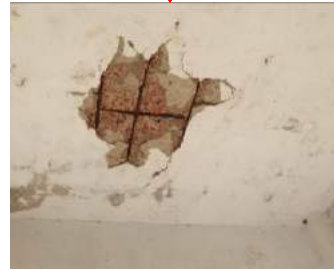
(d) Delamination and spalling of concrete in roof slab
