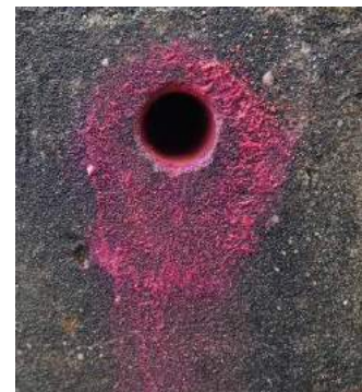
(d) Carbonation test on railing concrete showing no carbonation
