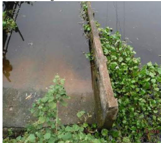
(d) Collapsed concrete deck in water
