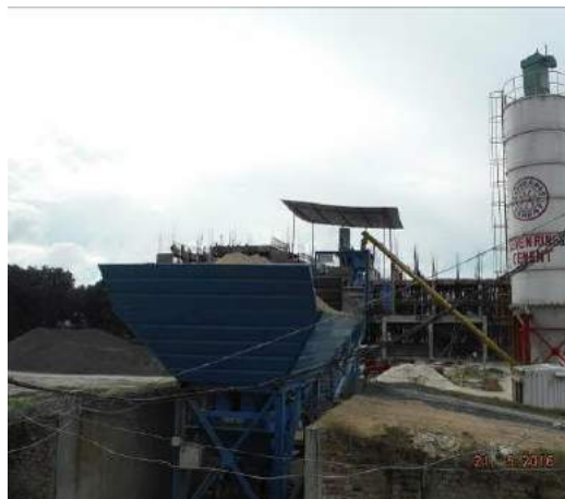
(d) Aggregate storage bins and cement silos
