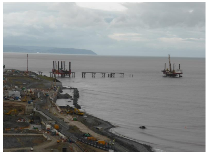
HPC Jetty Construction
