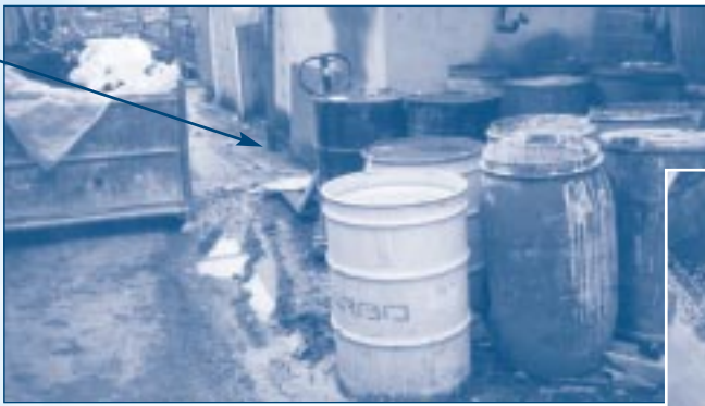
Cadw cemegau a thanwydd ger ac ar lethr i fyny o ddyfrdwl a gafodd ei gwblhau dan ddaear heb ffos yn y twll archwilio...
