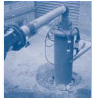
Blaenwaith ar yr wyneb (ymarfer da) (yn dal heb gael ei goncridio yn wastad â'r llawr), ond wedi ei lleoli ger cemegau wedi eu storio (ymarfer gwael)
