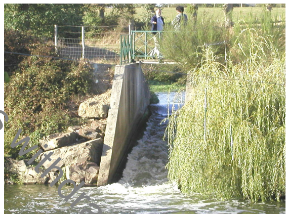
Figure 4.3.17. Pont Réan Weir eel pass
