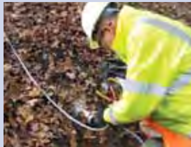
Wiring the anode
