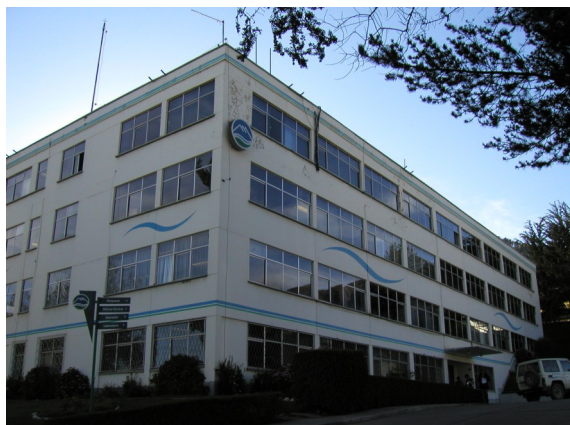
Aguas del Illimani Head Office
