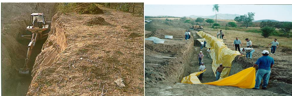
Figura 8. Barragem subterrânea: um exemplo de reservatório, a ser explorado por poços.
