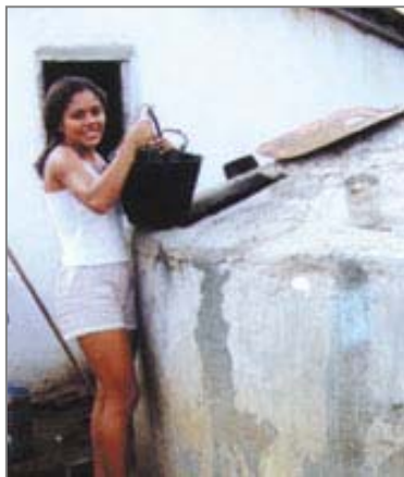
Figura 6. Cisterna, com detalhe da tampa de proteção.
