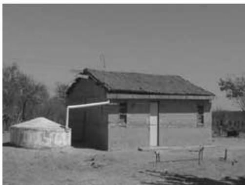
**Figura 4: Captação da água da chuva através da cisterna de placas**
