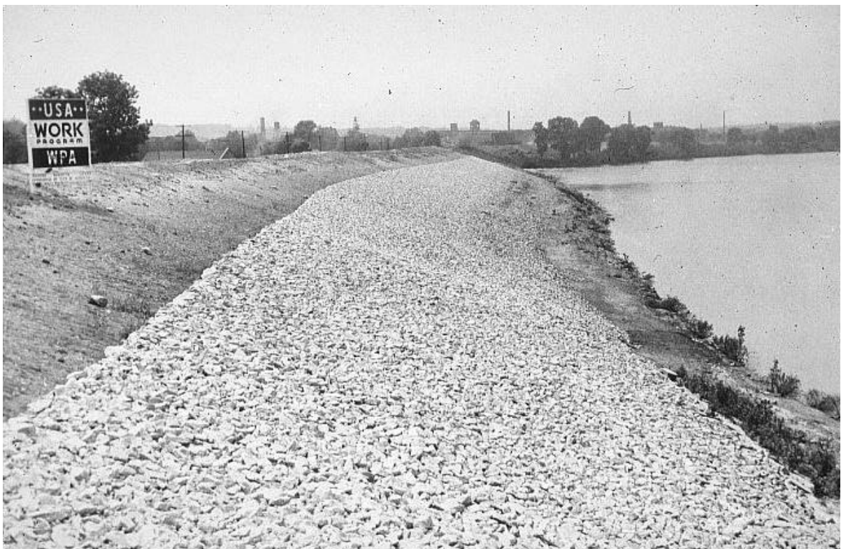
Figura 4.1 Dique de cheia nos EUA
