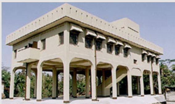
Figura 4.5 Exemplo de uma escola primária destinada a ser utilizada como abrigo contra ciclones no Bangladesh
