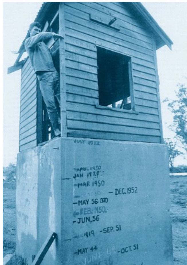
Figura 2.14 Casa de bomba com marcas de cheias na planície de cheia do Rio Snowy, Austrália com uma pessoa indicando o nível das cheias de Fevereiro de 1971
