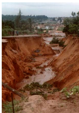
Erosão causada pelas cheias de 2000 em Maputo, Moçambique.
