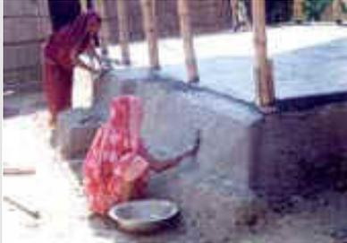
Os socos elevam as casas. Feitos com terra, um pouco de cimento e bocados de pedra e tijolo – robustos e suficientemente elevados, para suportar cheias repetidas, são diametralmente opostos aos tradicionais pavimentos de terra, que são simplesmente arrastados pelas águas.
