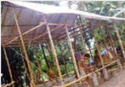
Escoras e juntas de fixação seguram as paredes com firmeza contra o 'esqueleto' da casa, mediante uma rede de buracos e entalhes – o chamado "sistema bivalve" local – e todo o edifício pode resistir aos temporais mais fortes.
