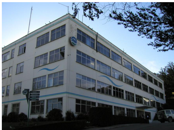
Aguas del Illimani Head Office
