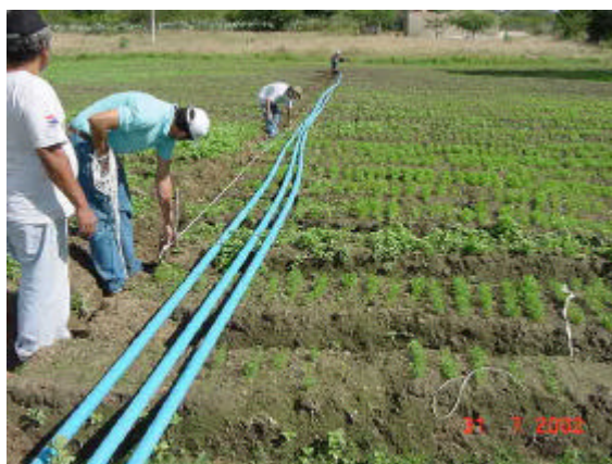
Figura 5 - Montagem do sistema de irrigação na área piloto de Cafundó II (Mutuca).
