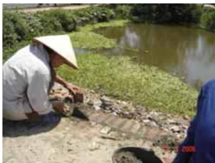
Edge Brick Repair
