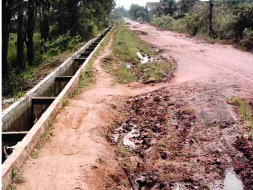
Hình 6 Mương thuỷ lợi cao hơn mặt đường và không có rãnh dọc
