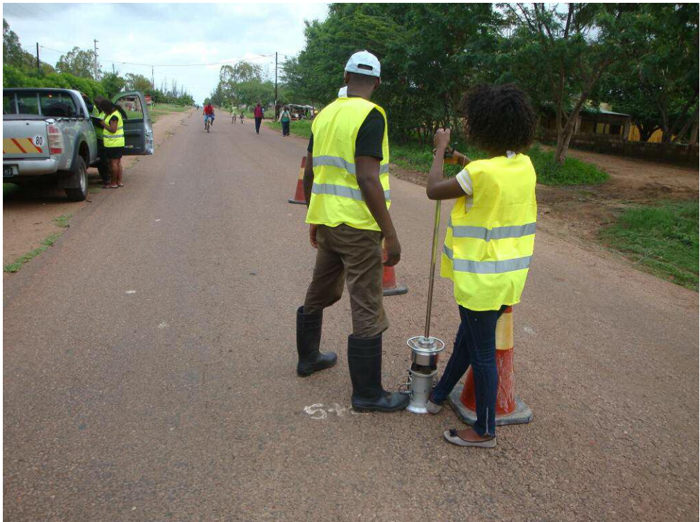
Deflection survey using PRIMA 100
