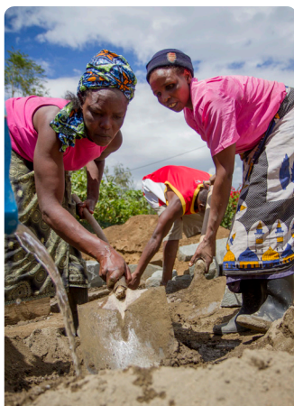
Mulheres a trabalhar na construção de latrinas em Naivasha, Quénia.
