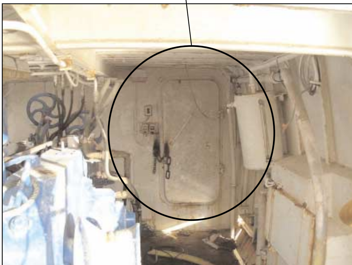
Porte de coursive à tribord
