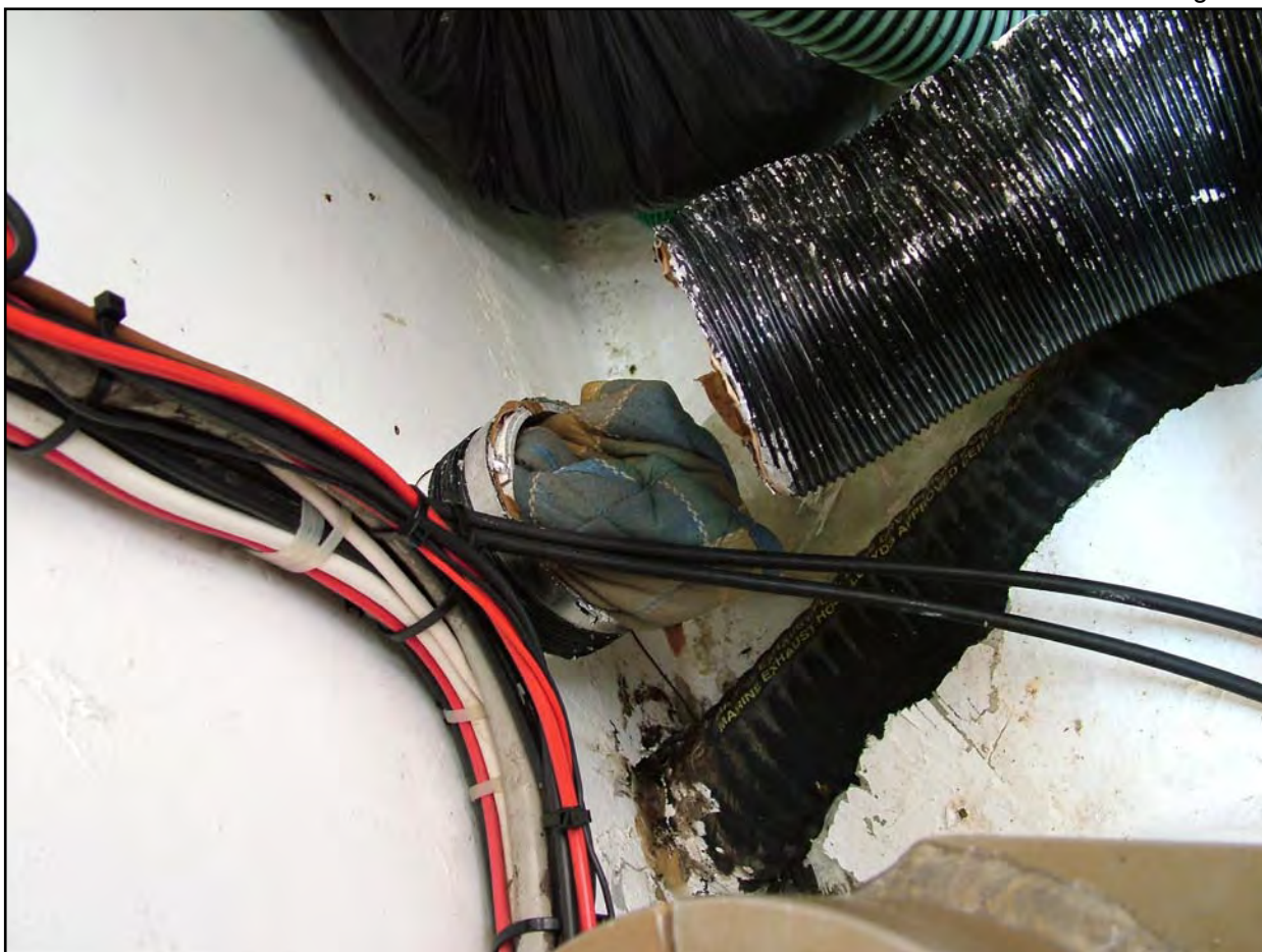
Sheared air conduit
